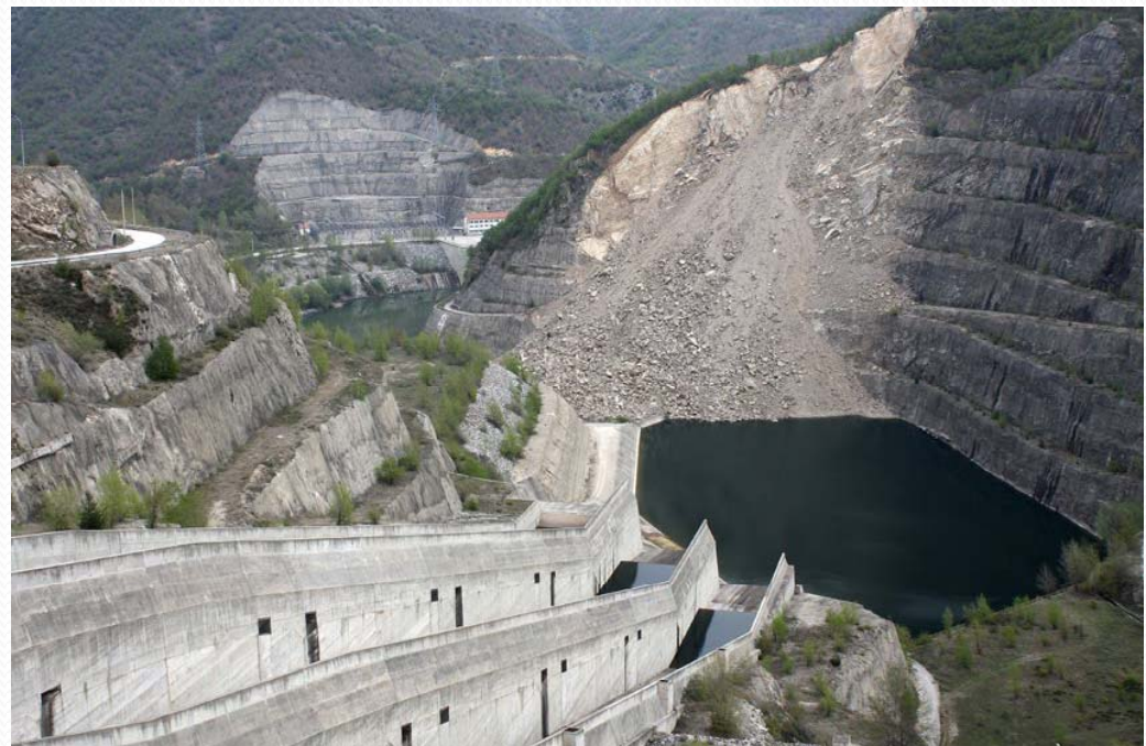
Κατολίσθηση Φράγματος Θησαυρού
