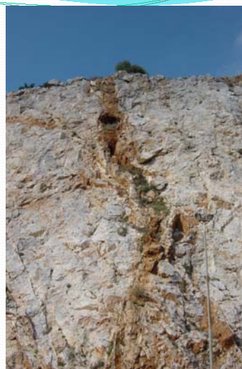
Εξαιρετικά πλατιά επιφάνεια ρήγματος πληρωμένη με αργιλικό και σταλαγμιτικό υλικό
